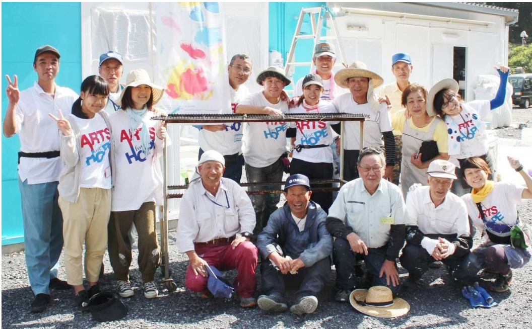
みんなで力を合わせ、1日目は下地とベース色の塗装が無事終了！
