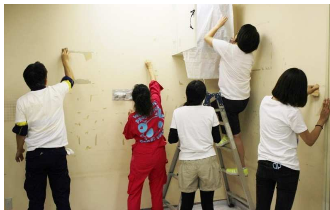
医療機器の移動、壁の下処理、養生、下地塗装、本塗装。 見事なチームワークで着々と作業が進行！
