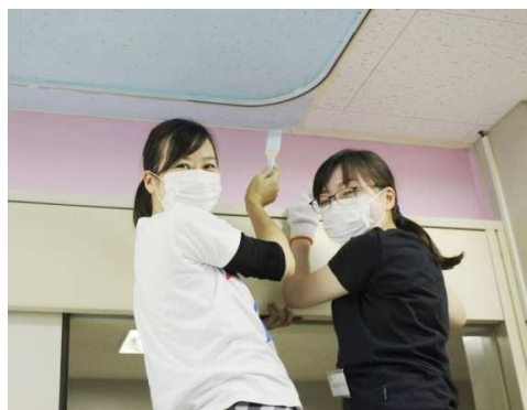
医療機器の移動、壁の下処理、養生、下地塗装、本塗装。 見事なチームワークで着々と作業が進行！
