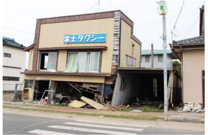
つぶれたままの建物
