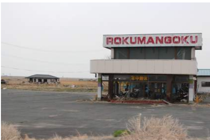
津波が突き抜けたままの建物
