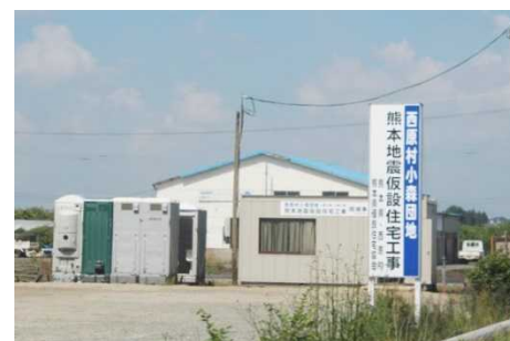
仮設住宅の建設が進められていた
