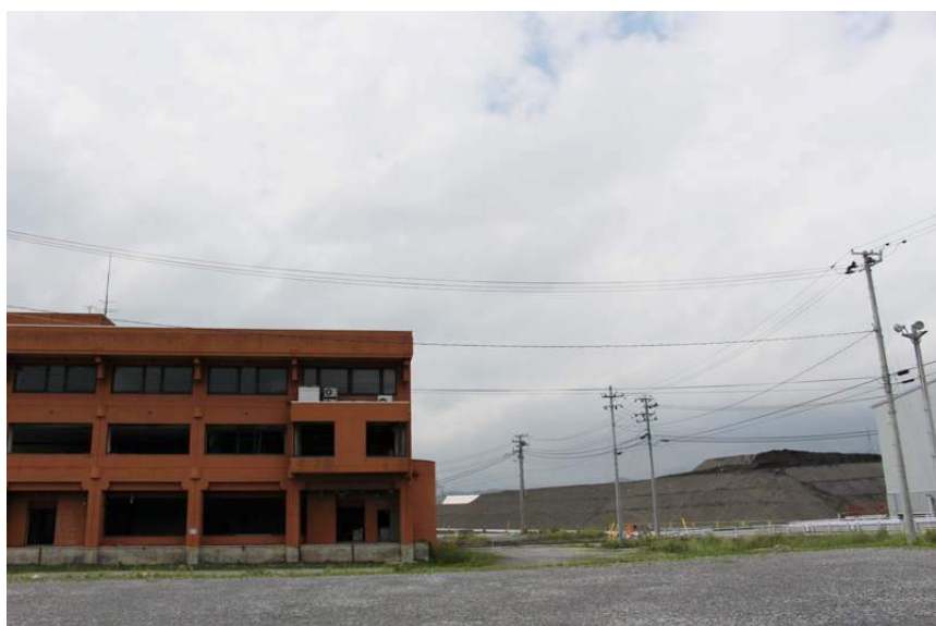
継続的な高上げ工事が進行中
