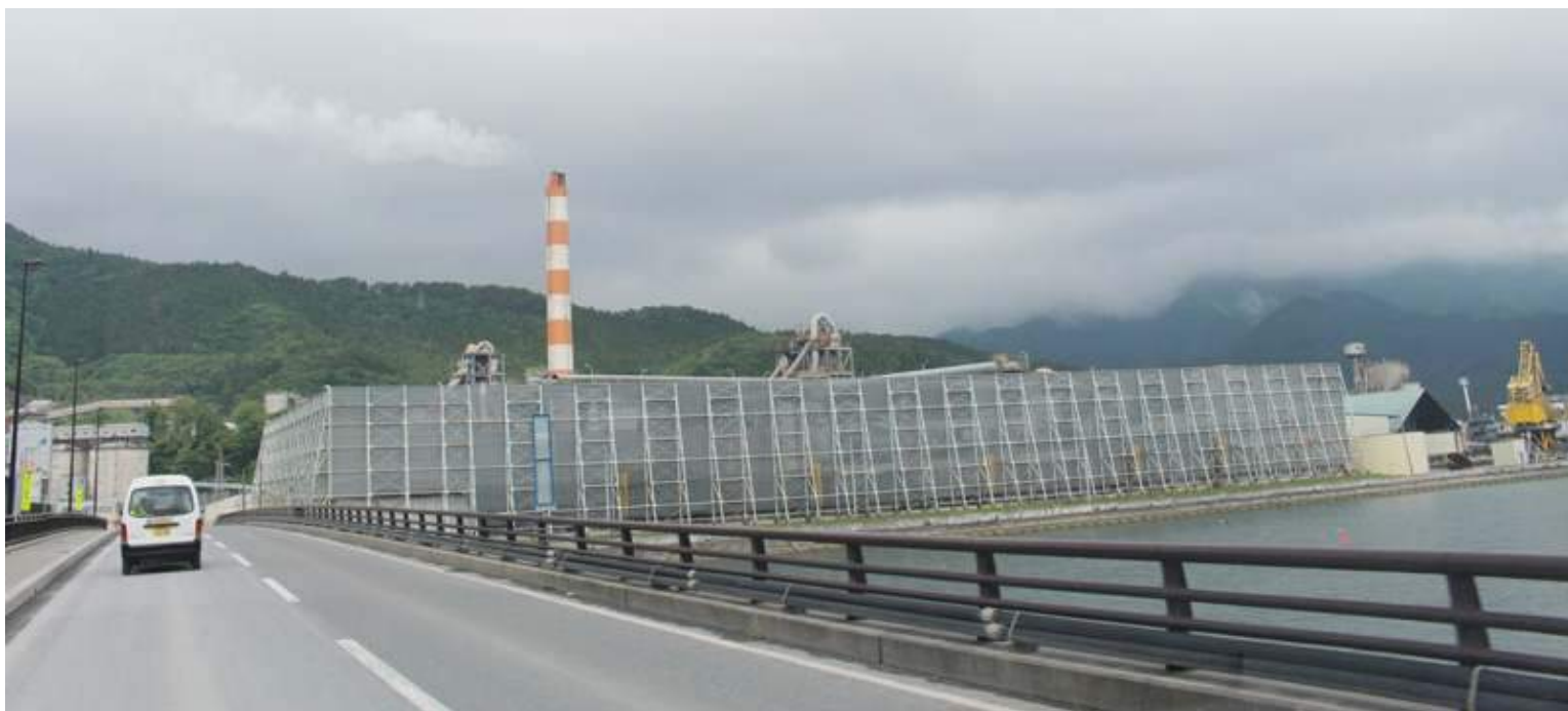
海を取り囲むように建設される防潮堤。海沿いの道路からも海は見えません。
