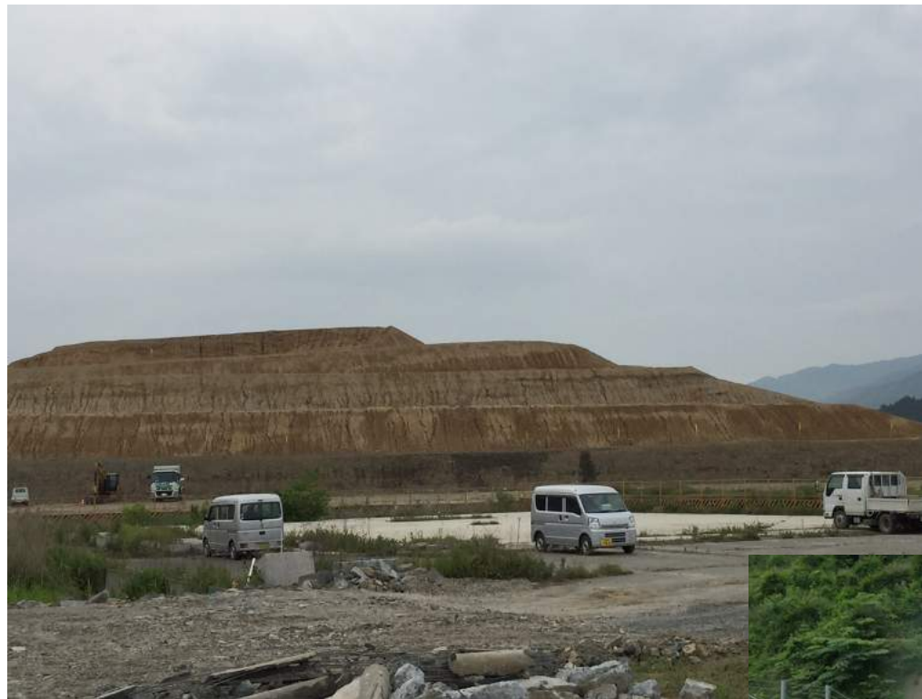
住宅地整備へ向けた工事が彼方此方で進められていた。 災害公営住宅周辺でも常時工事の音が聞こえている。
