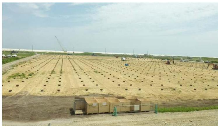
無数の太陽光発電機の設置作業が進められていた。見渡す限り一面パネルの土台が設置されている。
